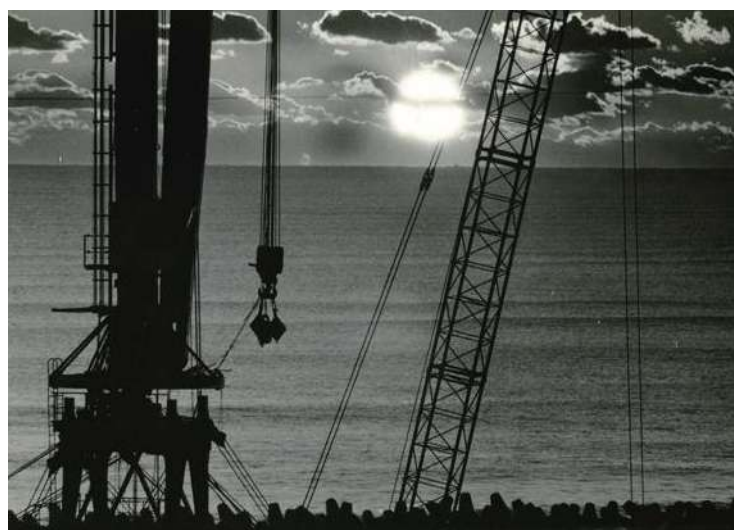
原発工事のクレーン越しに昇る朝日(公民館報 49号)
