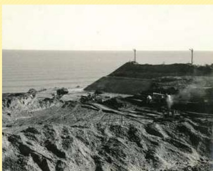
原子力発電所 建設工事の様子
