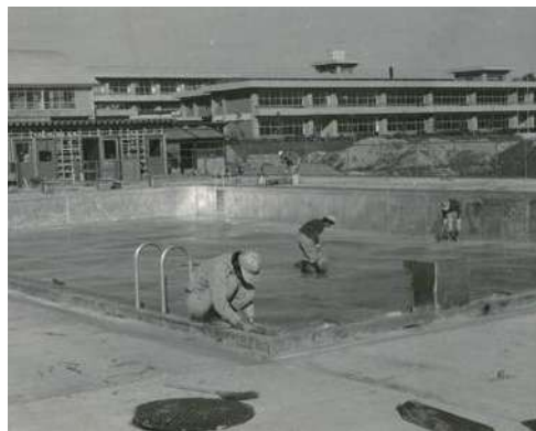
建設中の大熊中プール
