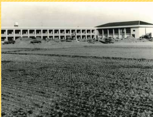
完成間近の大野小学校
