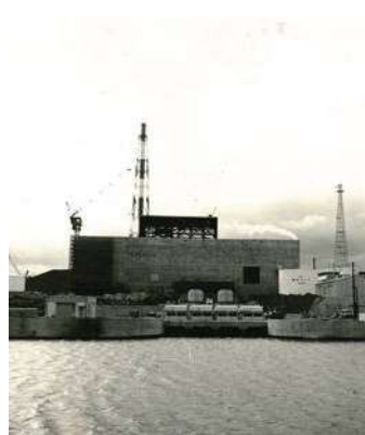
昭和44年当時の原子力発電所1号機
