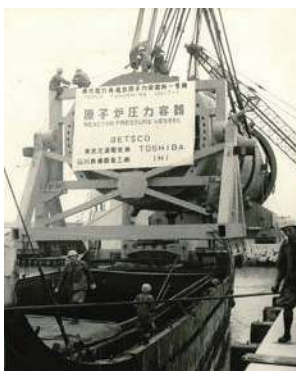
原子炉圧力容器の陸揚げの様子(公民館報 57号)
