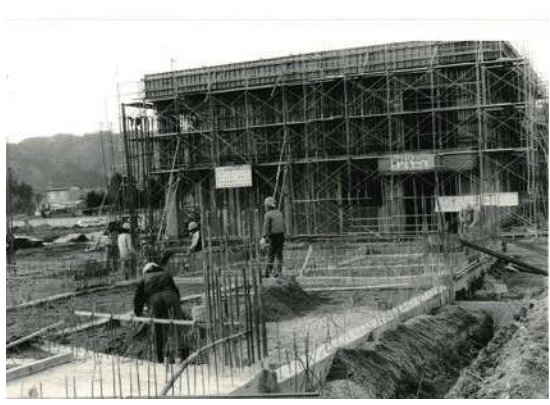
大野小新校舎の工事の様子
