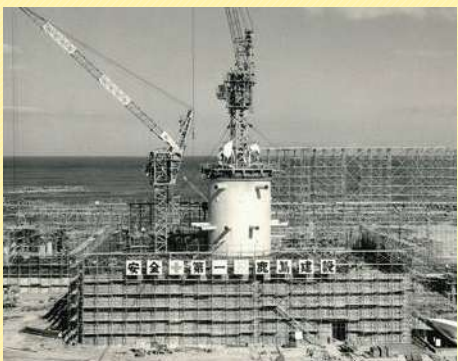
原子力発電所 建設工事の様子
